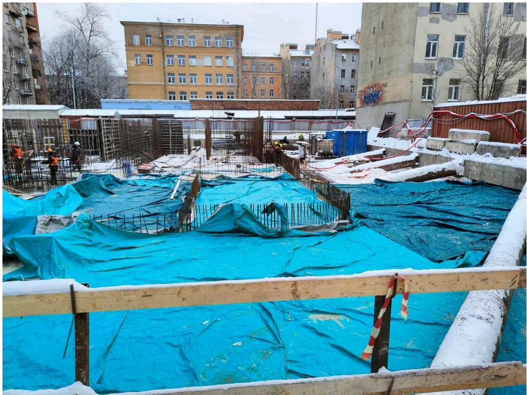
Уход за бетоном после бетонирования плиты перекрытия над подвалом и армирование стен техэтажа
