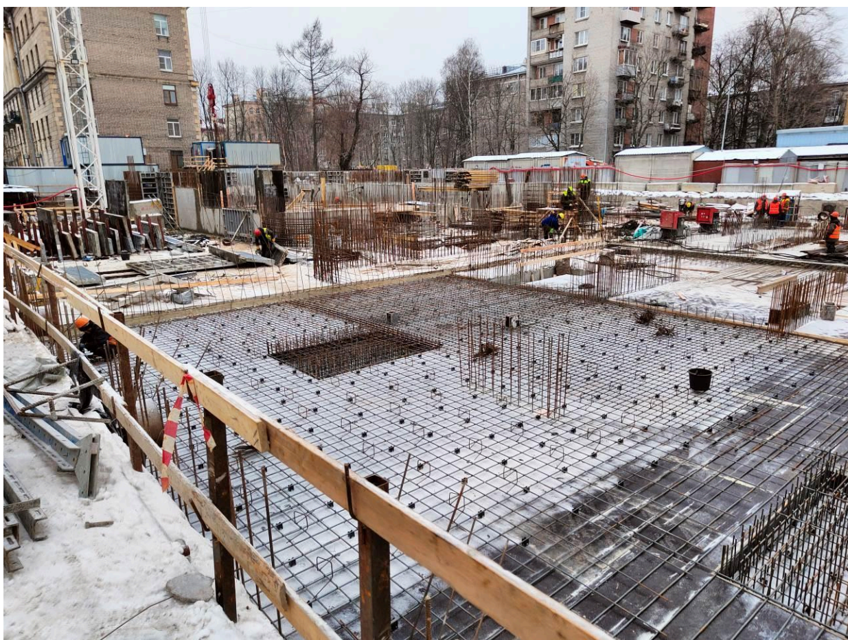
Армирование плиты перекрытия над подвалом
