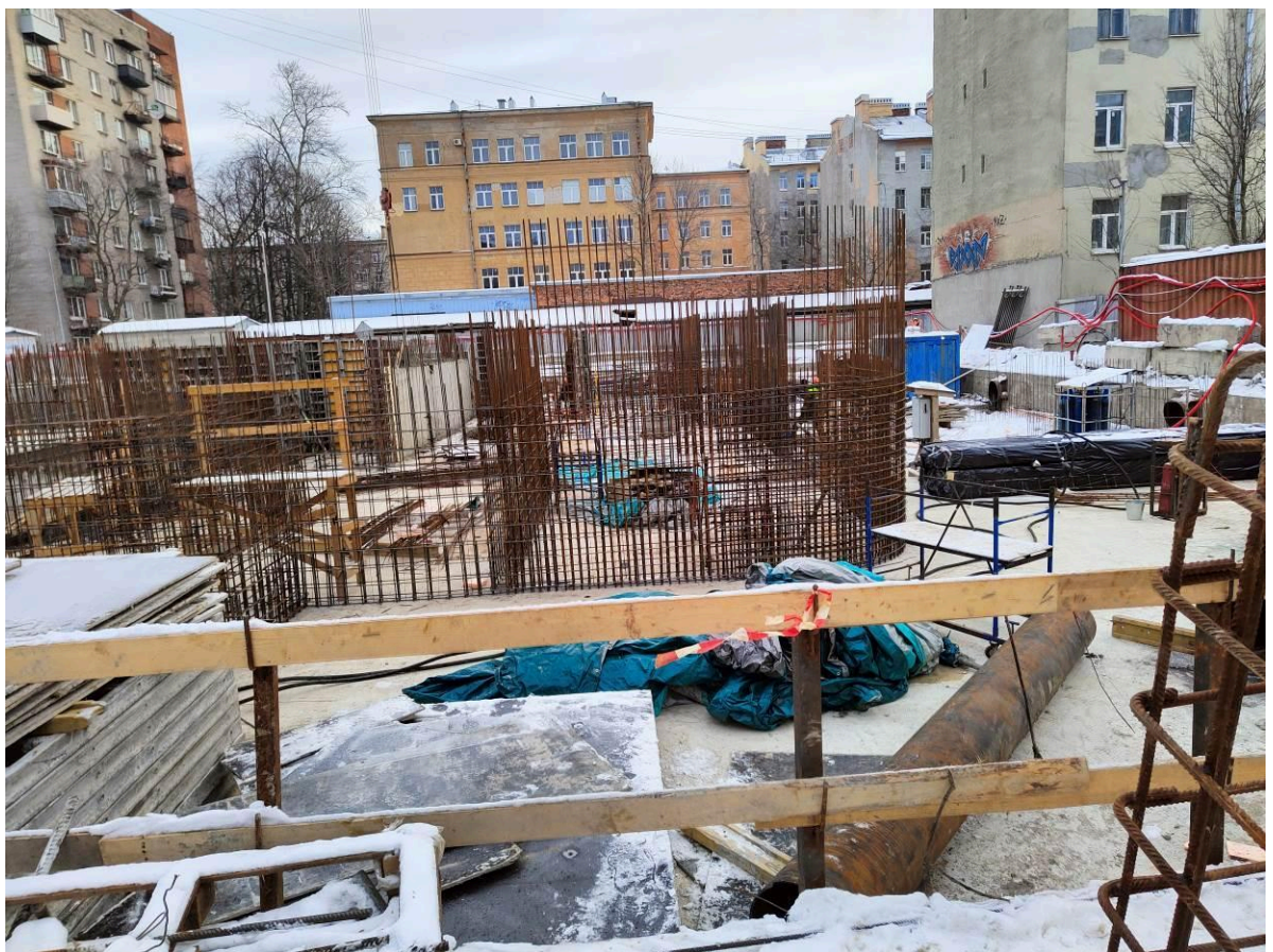
Армирование стен техэтажа
