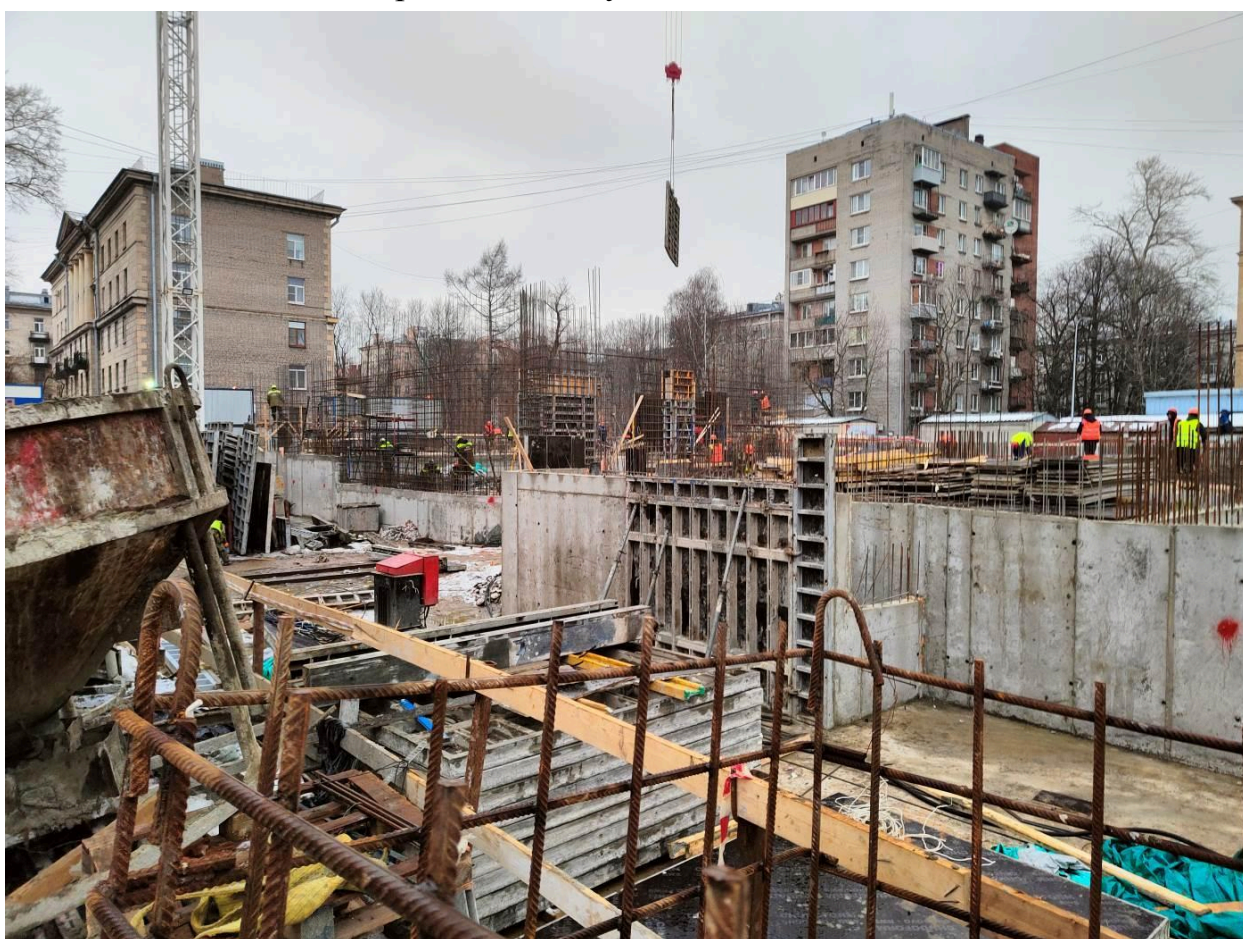
Устройство опалубки стен техэтажа
