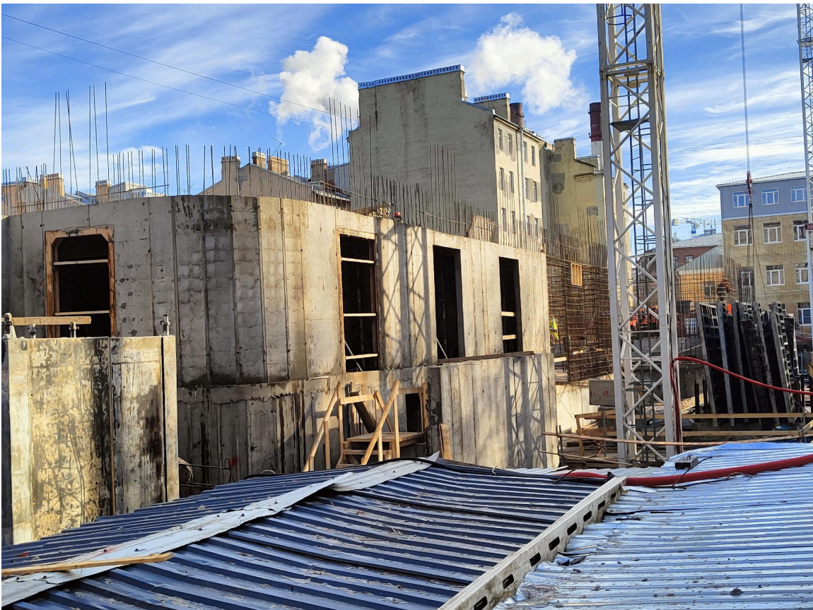
Бетонирование стен 1-го этажа
