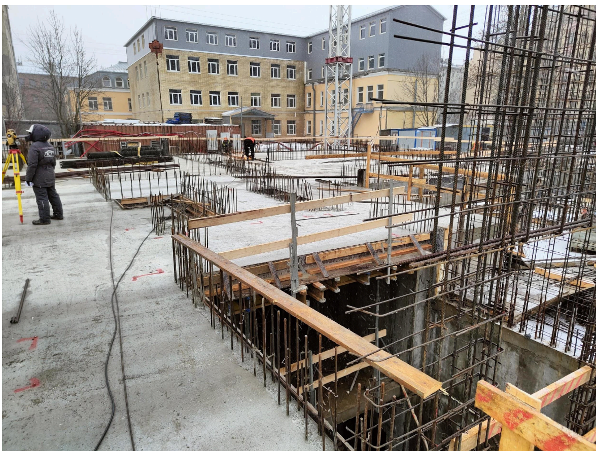
Бетонирование плиты перекрытия тех. этажа
