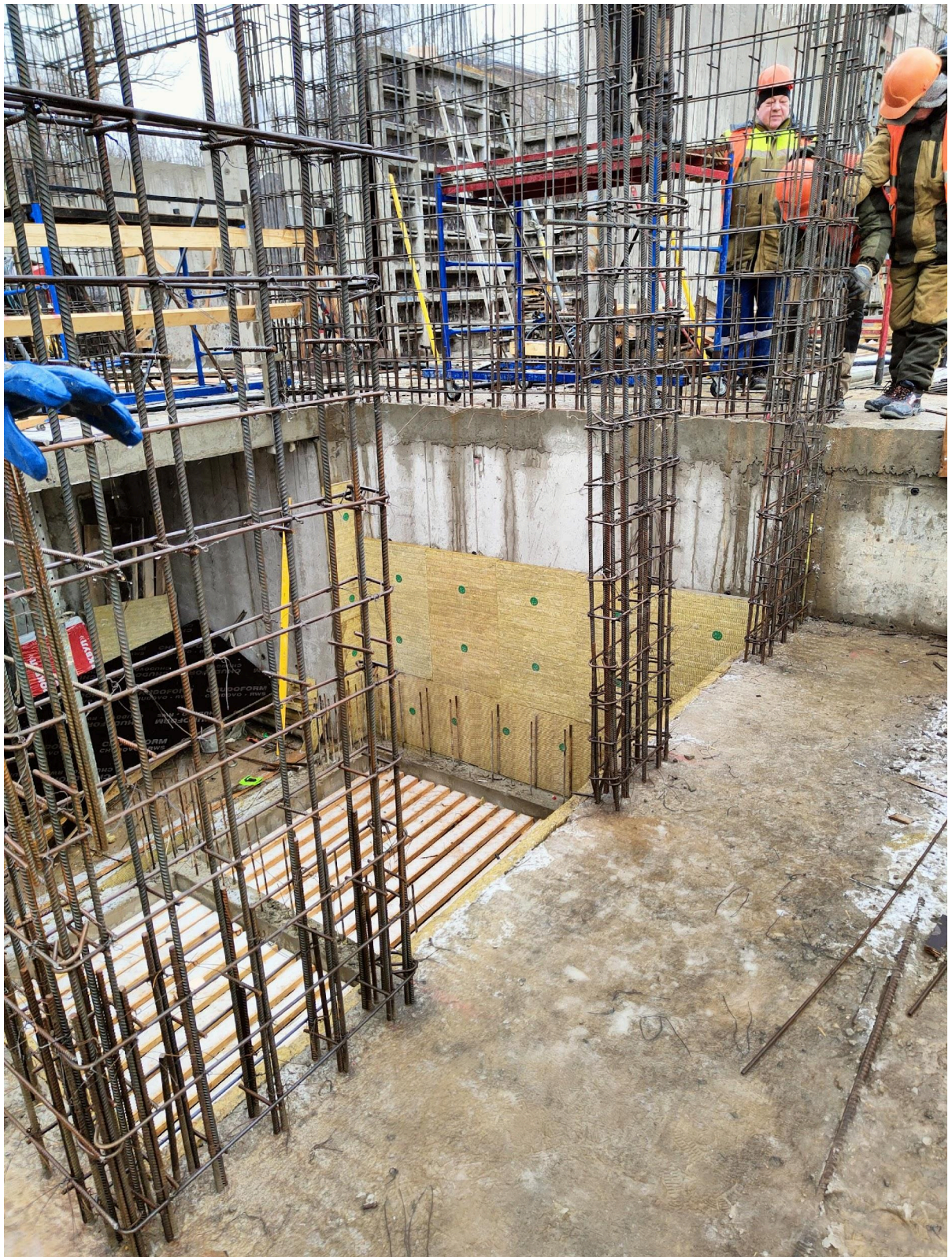
Армирование стен 1-го этажа
