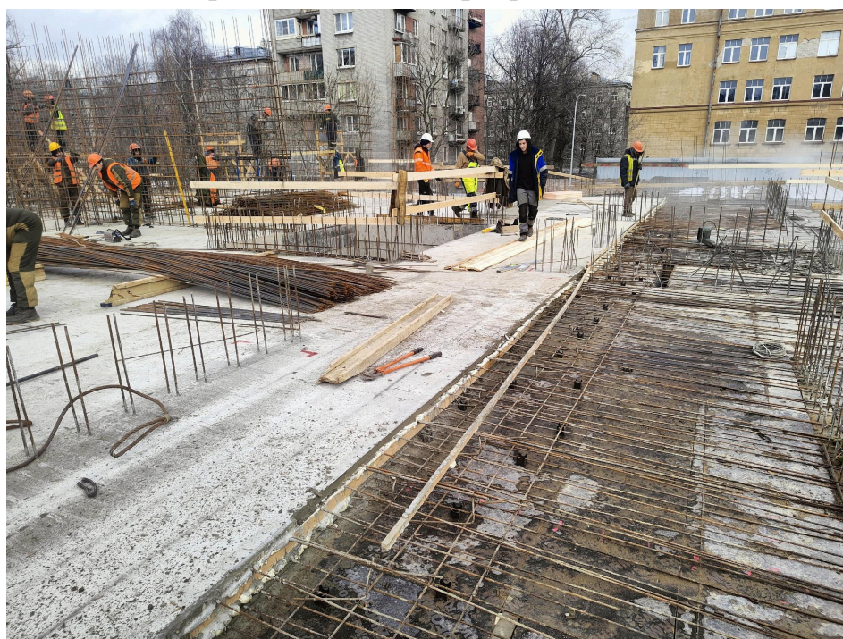
Устройство перекрытия 1-го этажа
