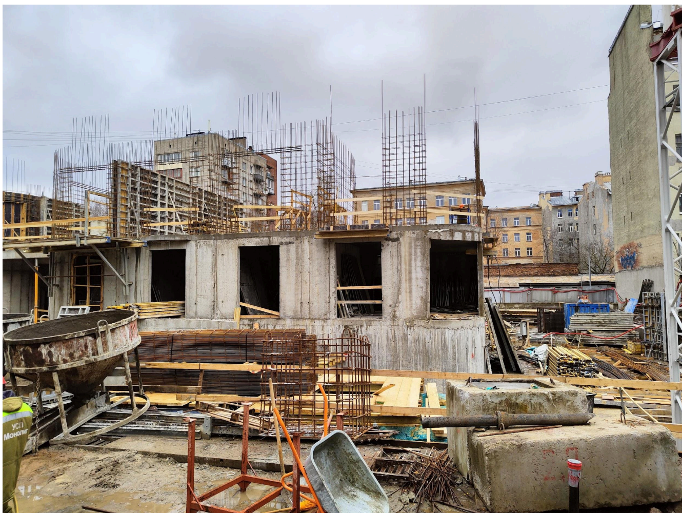
Устройство стен 2-го этажа
