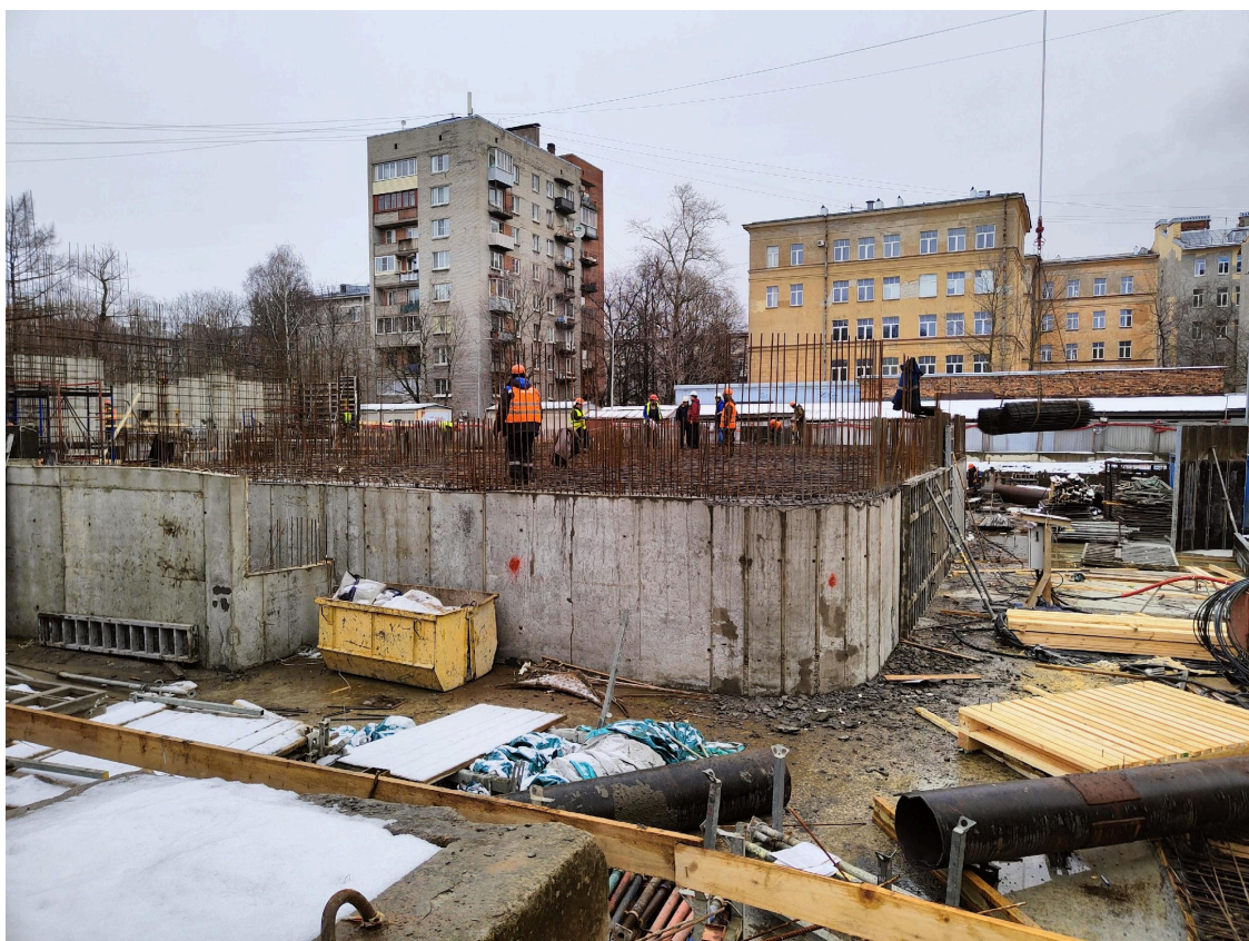
Армирование плиты перекрытия тех.этажа
