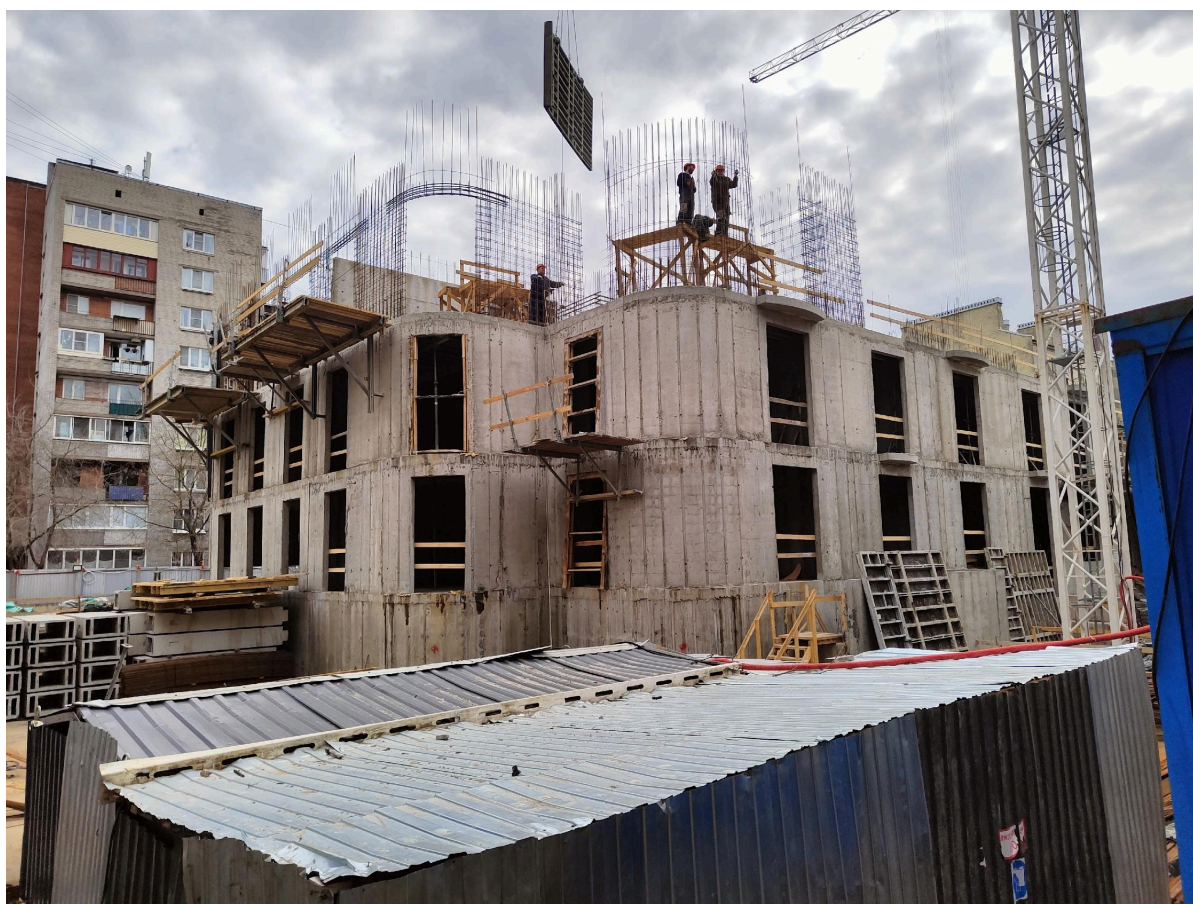
Армирование стен 3-го этажа
